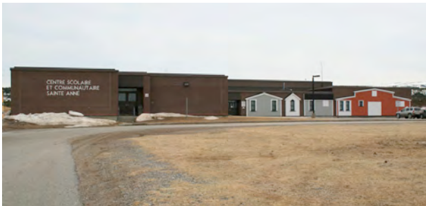
Centre scolaire et communautaire Ste-Anne Photo : ARCO
