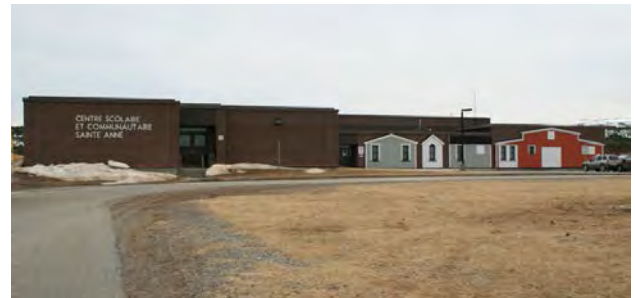
Centre scolaire et communautaire Ste-Anne Photo : ARCO
